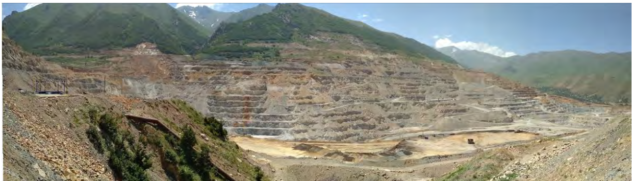
Լուսանկար 3. «Զանգեզուրի պղնձամոլիբդենային կոմբինատ» ՓԲԸ-ի կողմից շահագործվող Բացհանքի լեռնահատկացման տարածքում բացված դարավանդաձև կտրվածքները
