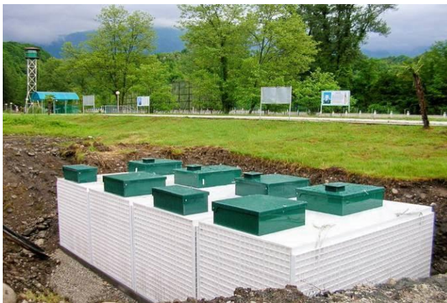
Նկար 3. ЮНИЛОС АСТРА 300 տիպի խորը կենսաբանական մաքրման սարքավորման տեսքը
